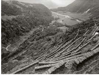
Trockensteinmauern sichern die Berninabahn bei der Alp Grüm GR vor Steinschlag und Lawinen. In den ersten Jahren nach der Eröffnung der Bahn 1910 war der Steilhang kaum bewaldet. Coverfoto von Albert Steiner (1877–1965) um 1925, Archiv der RhB, Chur.
