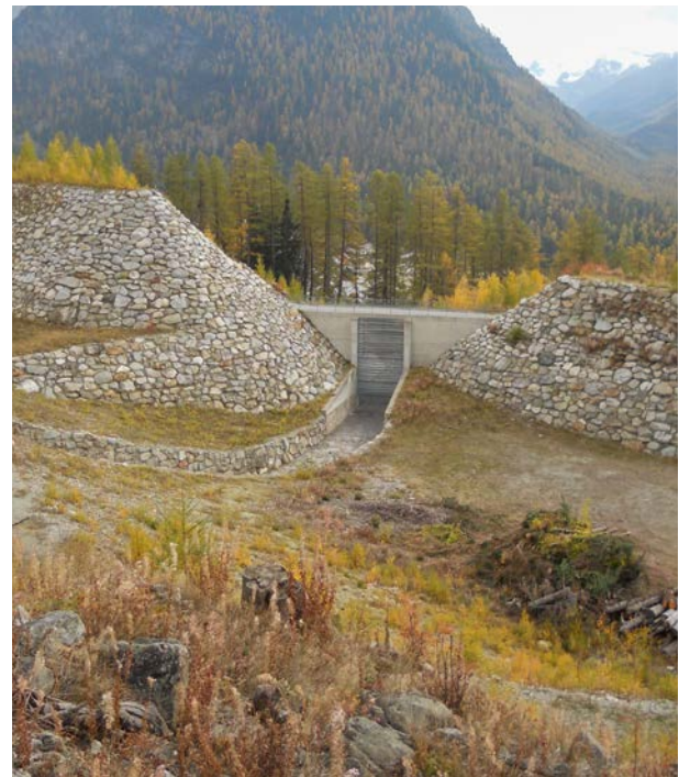
Die beiden Hauptdämme sind 205 und 230 m lang, an der Basis 70 m breit und bergseitig 12 m hoch.
