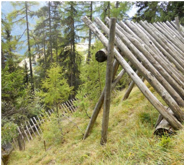
Temporäre Verbauungen aus Holz leisten ihren Dienst, bis die Bäume die Schutzfunktion übernehmen.
