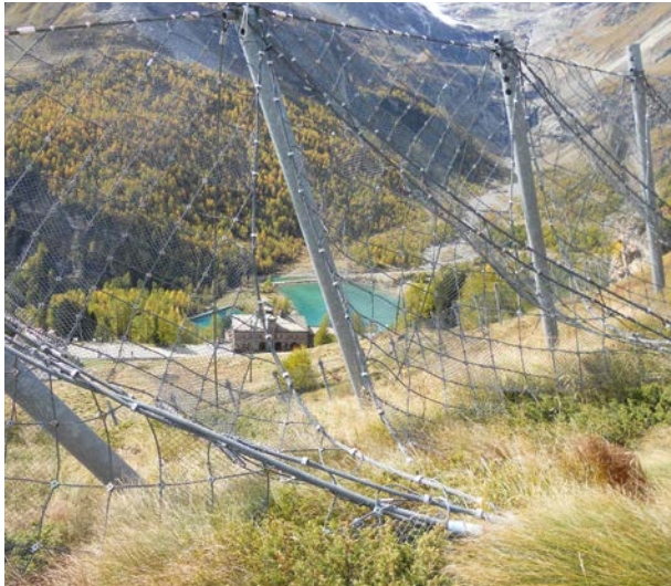
Schneenetze halten den Schnee zurück und verhindern dessen Abgleiten.
