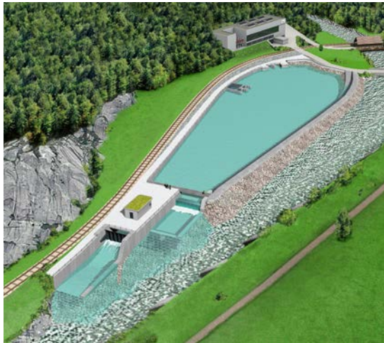
Schwalldämpfungsbecken bei Innertkirchen BE (Visualisierung); Bauzeit 2012–2016.
