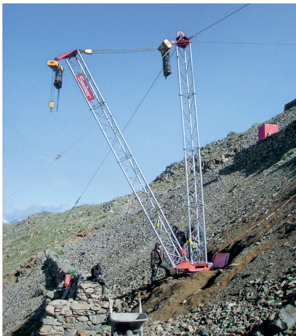
Für die Instandstellung der Steinmauern entwickelte eine in Pontresina ansässige Firma einen flexibel einsetzbaren Kran . Foto: Amt für Wald und Naturgefahren Graubünden
