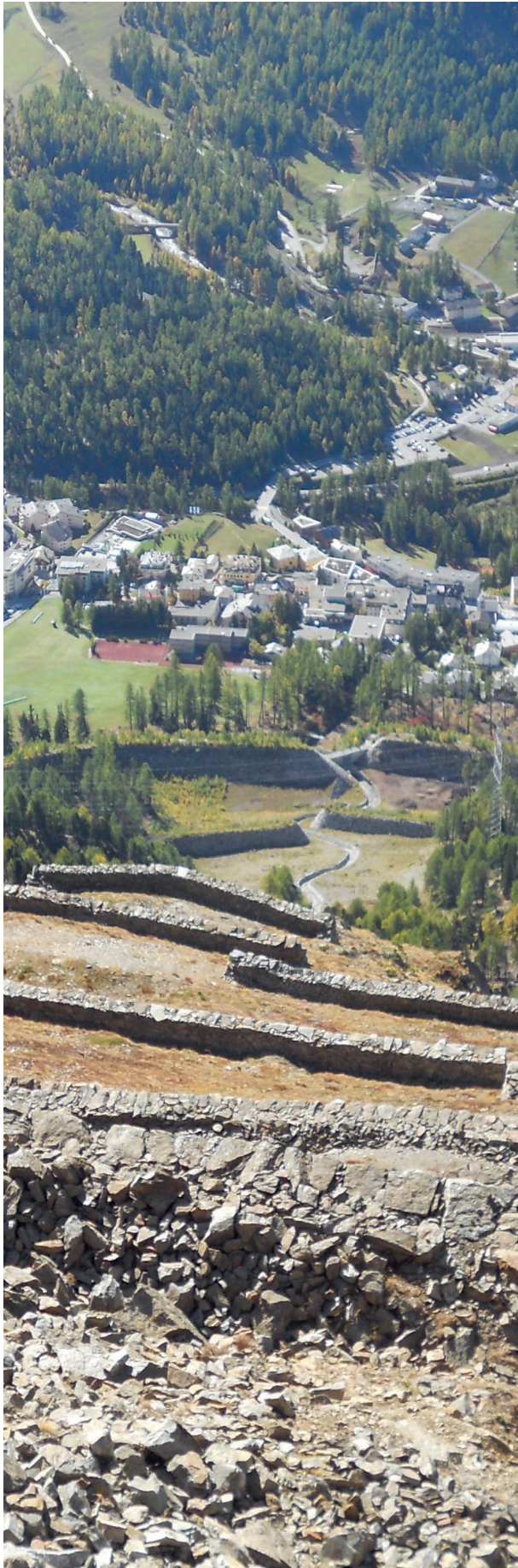
Seit 2003 schützen auch Auffangdämme das Siedlungsgebiet vor Murgängen und Lawinen.
