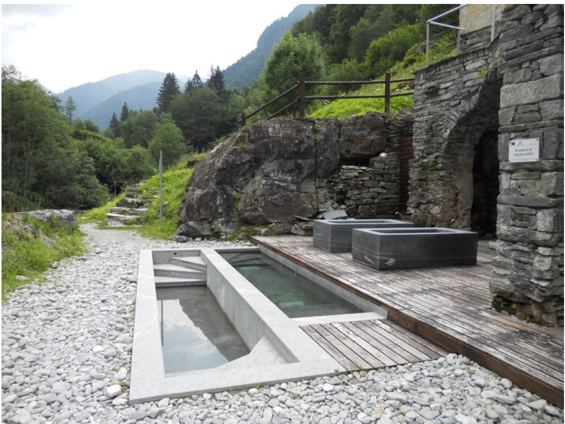
Sanfte Restaurierung – die zwei neuen Wannen sind aus Granit aus dem Onsernonetal gefräst.
