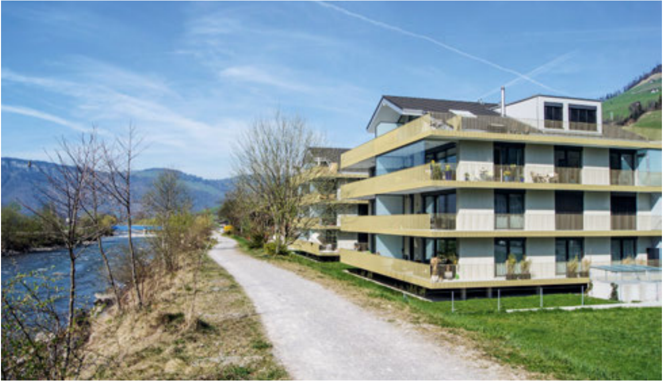
Haus auf Stelzen in Büren/Oberdorf NW: Der bauliche Objektschutz an dieser Immobilie an der Engelberger Aa stellt sicher, dass das Hochwasser nicht ins Gebäude eindringt, ungehindert abfließen kann und nicht auf die Nachbarparzellen seitlich abgeleitet wird. Architektur: Kontur Architekten, Stans.
