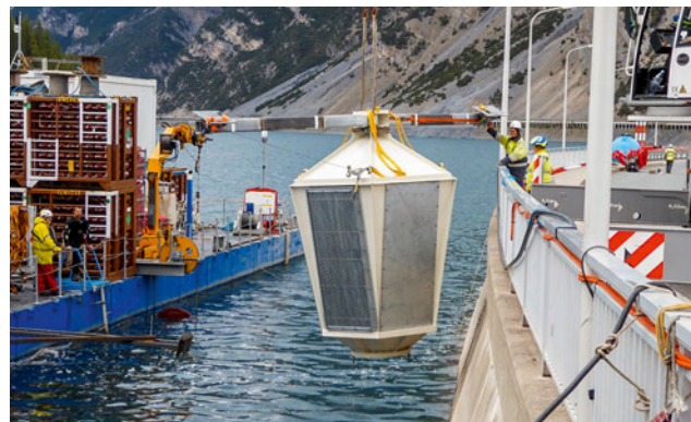
Der Trompeteneinlauf des künftigen Dotierwassereinlaufs wird in den See abgesenkt.
