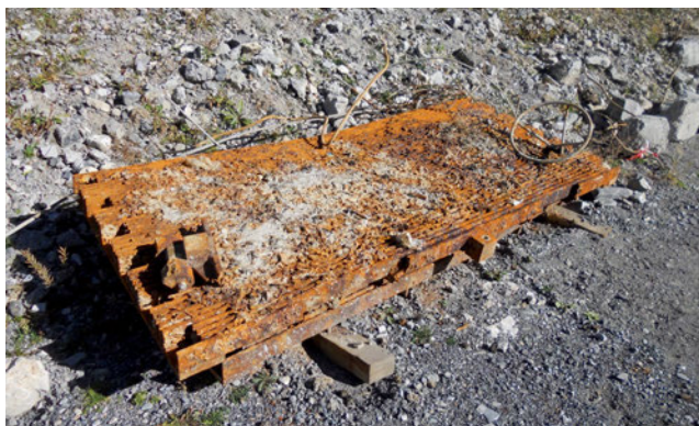
45 Jahre lang im Einsatz: der alte Rechen des Dotiereinlaufs.
