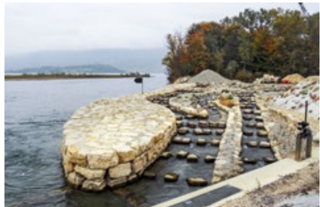
Das Umgebungsgewässer bietet kleineren und grösseren Fischen verschiedene Auf- und Abstiegsmöglichkeiten an.
