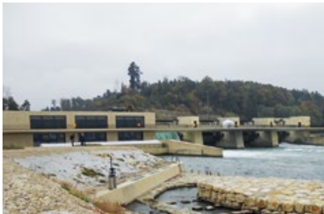
Das Maschinenhaus ist in das Wehr integriert. Über die Wehrbrücke führt eine beliebte Veloroute entlang des Bielersees.
