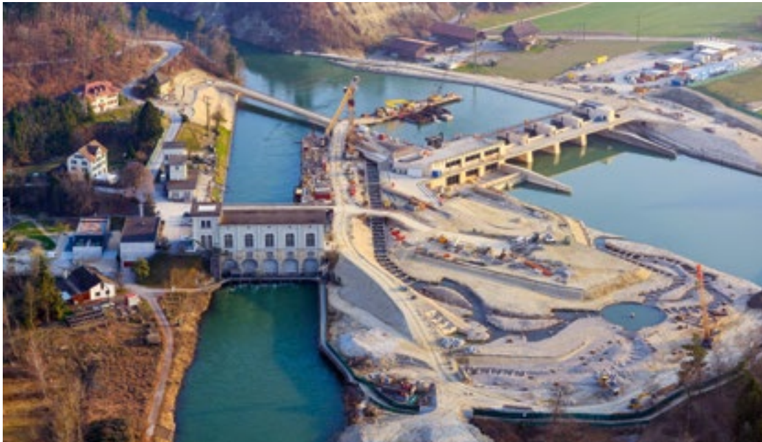
Altes und neues Kraftwerk Hagneck mit dem Umgehungsgewässer in einer Aufnahme vom März 2015.
