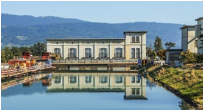
Im alten Maschinenhaus bleibt eine Turbine in Betrieb. Künftig dient das Gründungskraftwerk der BKW Schulklassen und Besuchern als Anschauungsobjekt.
