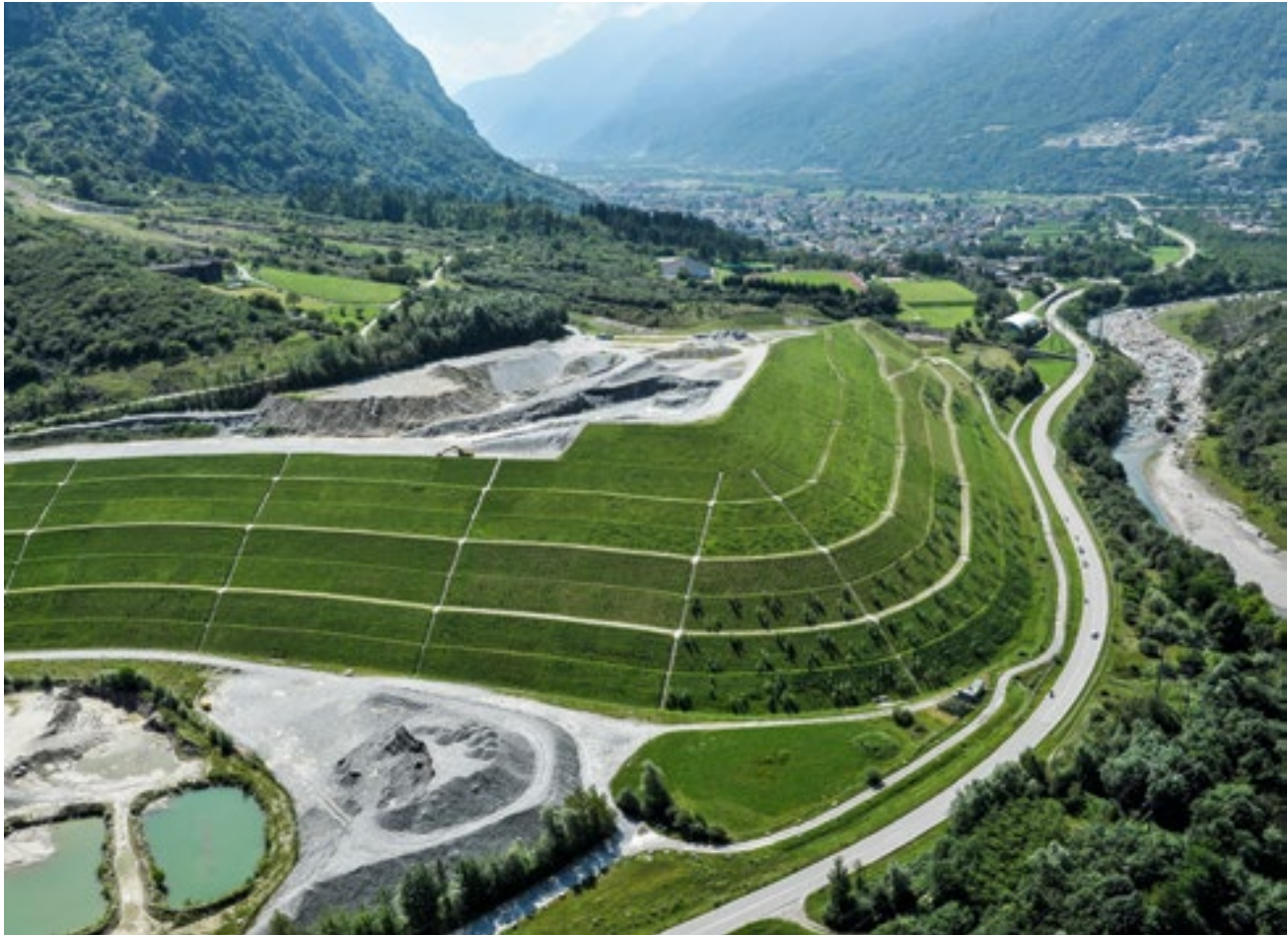
Materialdeponie «Buzza di Biasca»: Das Ausbruchmaterial der Tunnellose Bodio und Faido gelangte über eine Förderbandanlage vom Installationsplatz Bodio ins benachbarte Bleniotal. Dort wurde es in einem ehemaligen Bergsturzgebiet aufgeschichtet.
