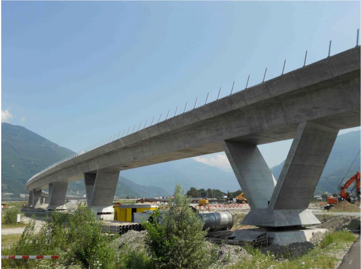
In weitem Bogen auf V-förmigen Stützen führt die Brücke vom Nordportal bei Camorino Richtung Bellinzona.
