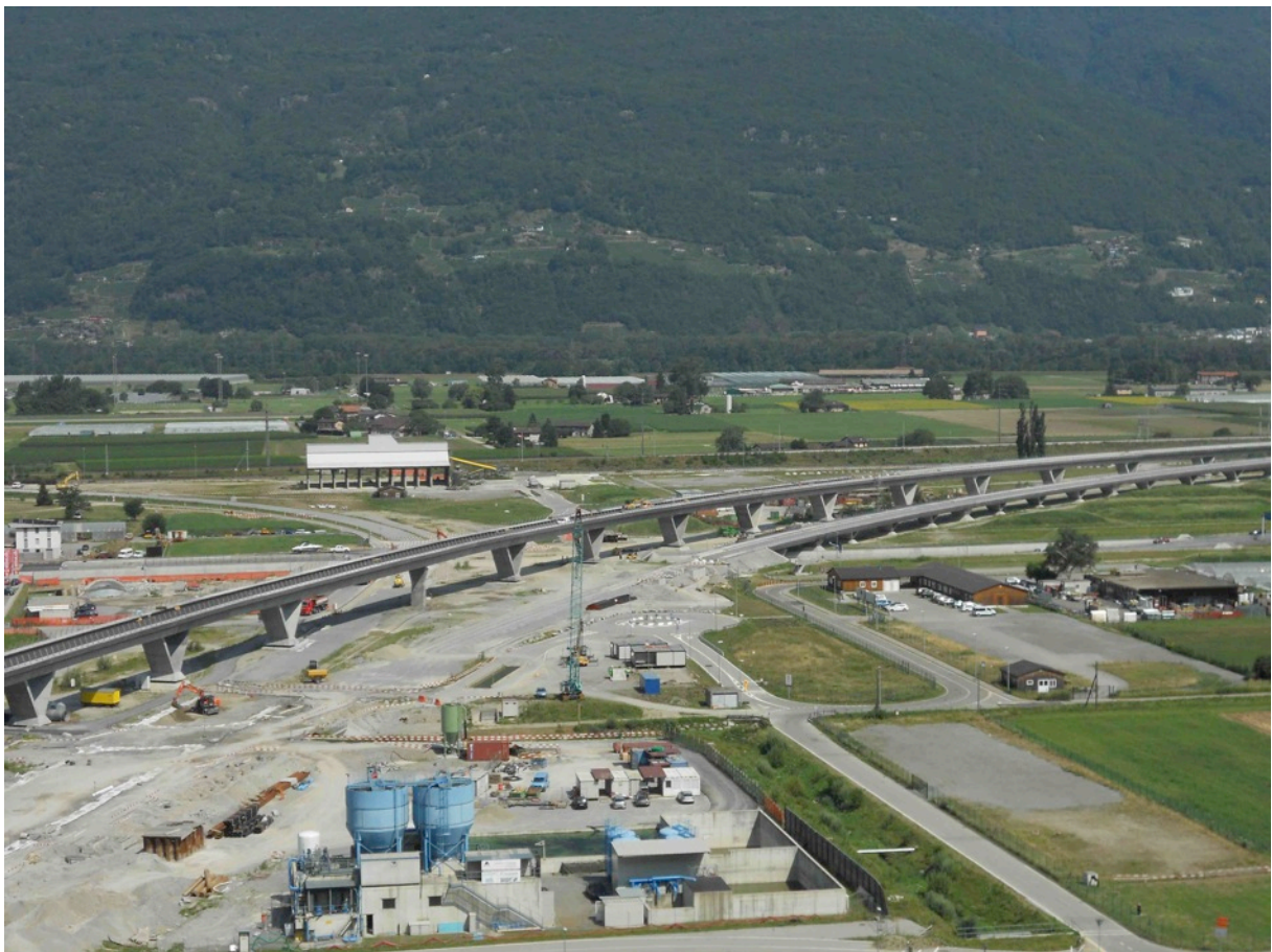
Gewaltiges Bauwerk: Die Brücke war nötig, weil Autobahn und Kantonsstrasse überquert werden mussten.
