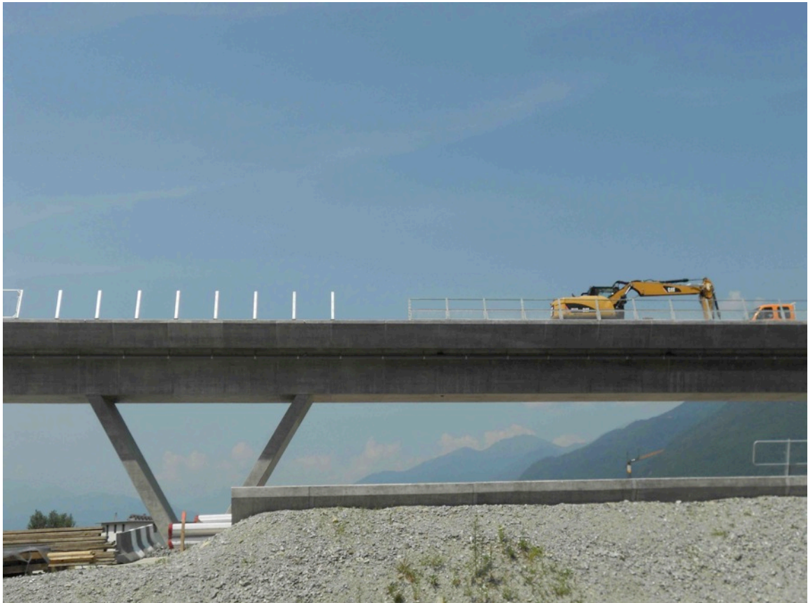
Baumaschinen auch auf der Brücke.
