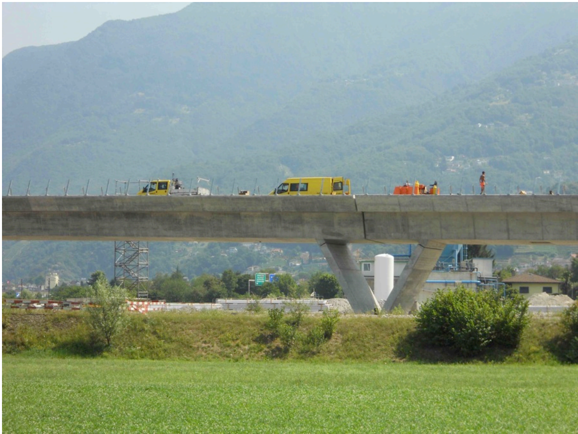
Eine Baustelle mit Aussicht ...
