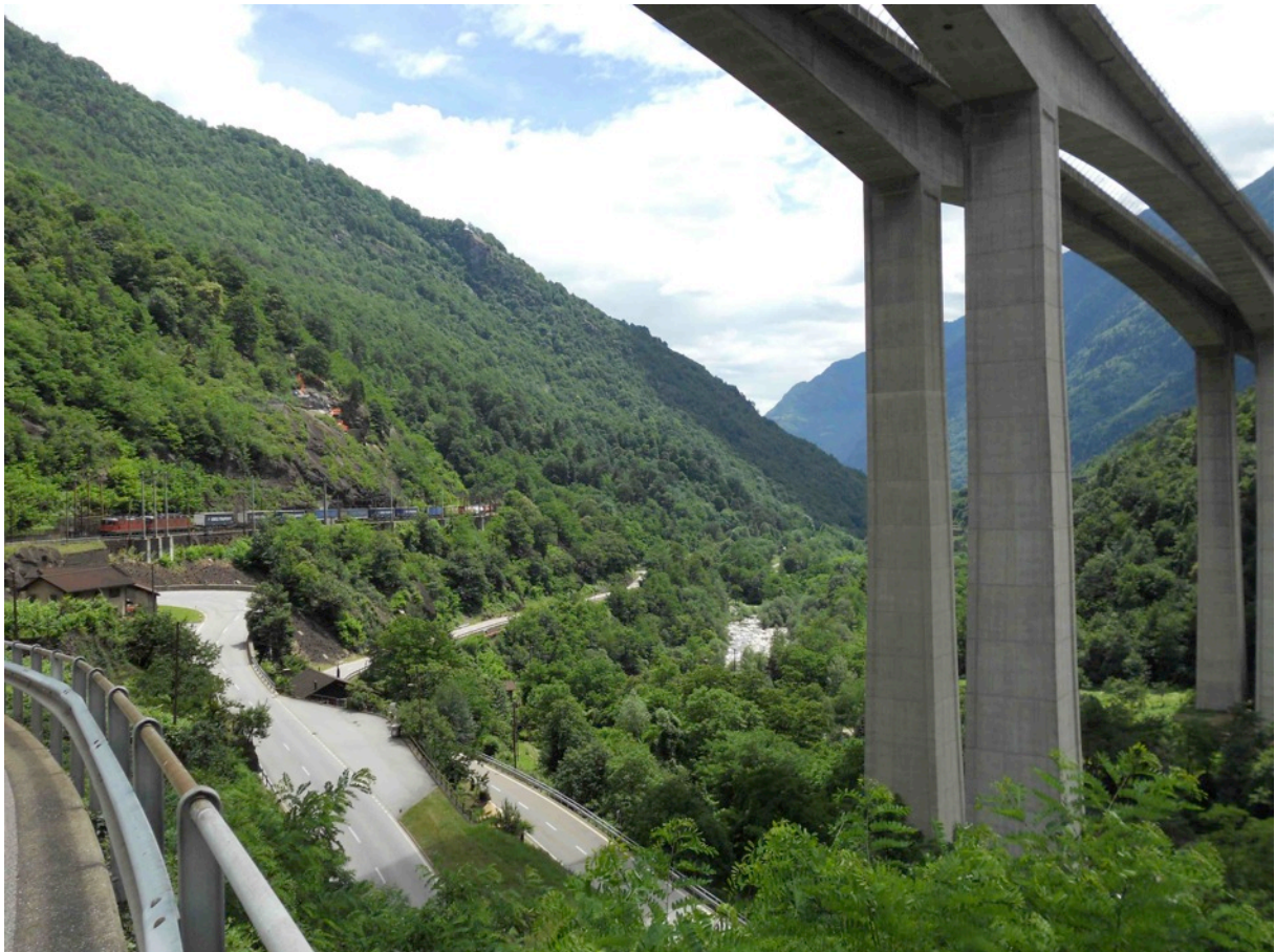
Autobahn, Kantonsstrasse und Eisenbahn in der Biaschina.
