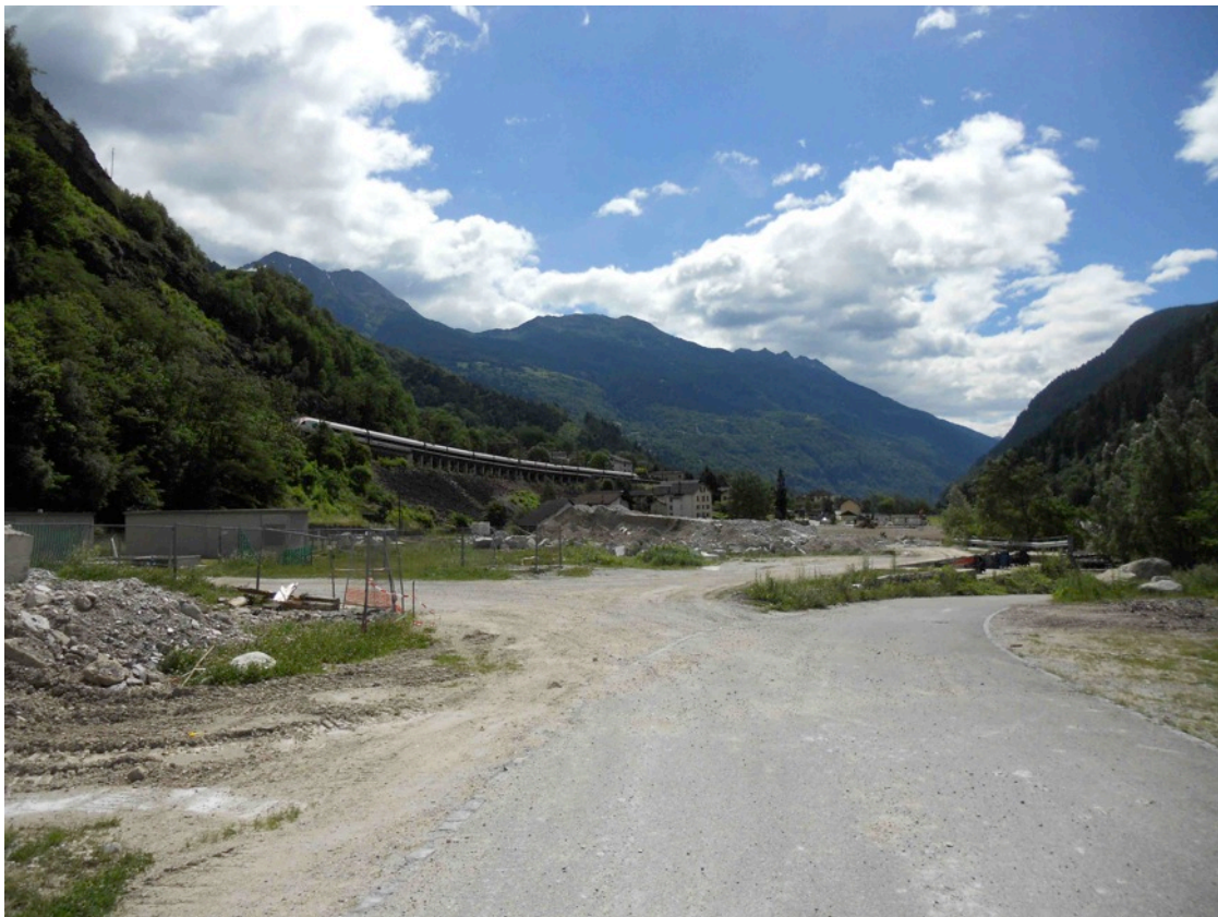
Von der Alptransit-Baustelle in Faido ist nicht mehr viel zu sehen. Der Zugangstollen zum Tunnel wird künftig für die Stromversorgung der Züge im Tunnel benutzt.
