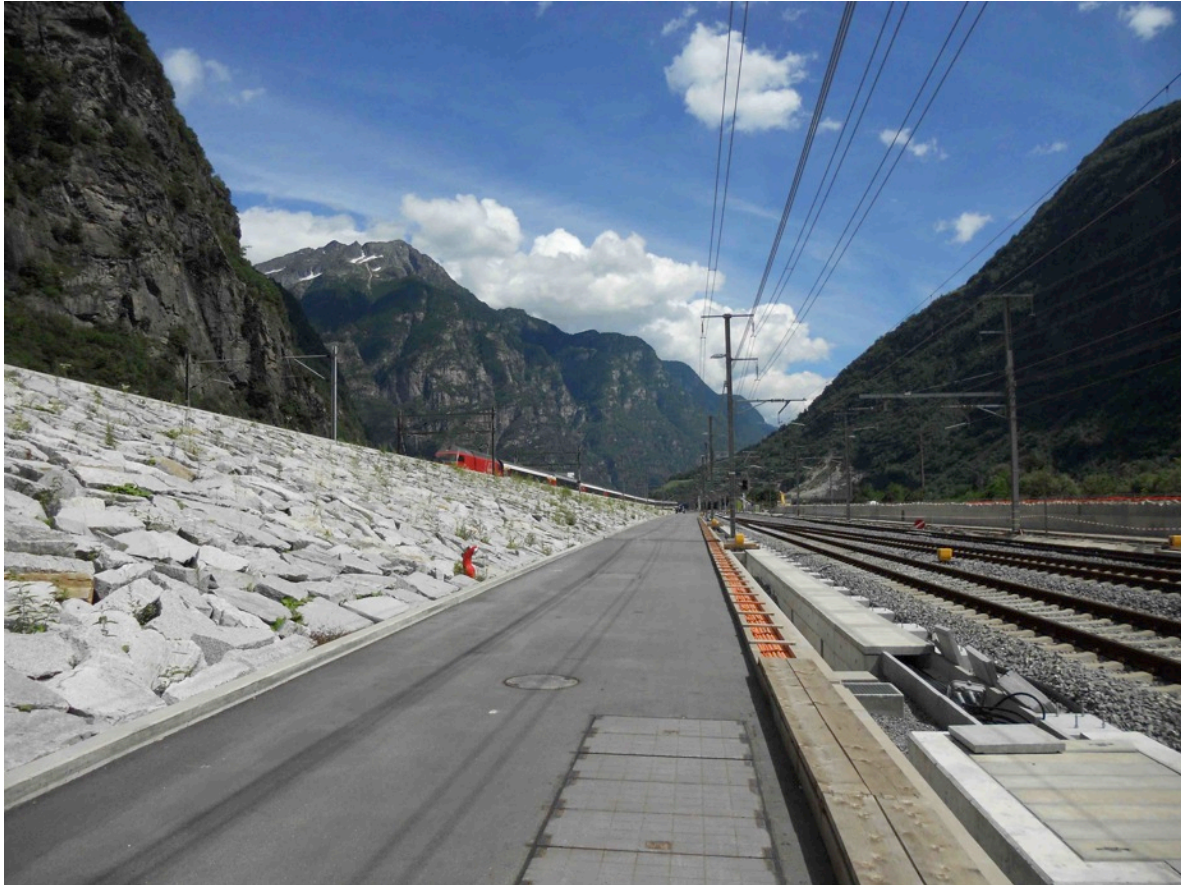
Die alte Strecke links, die Zufahrt zum Südportal des Gotthard-Basistunnels rechts.
