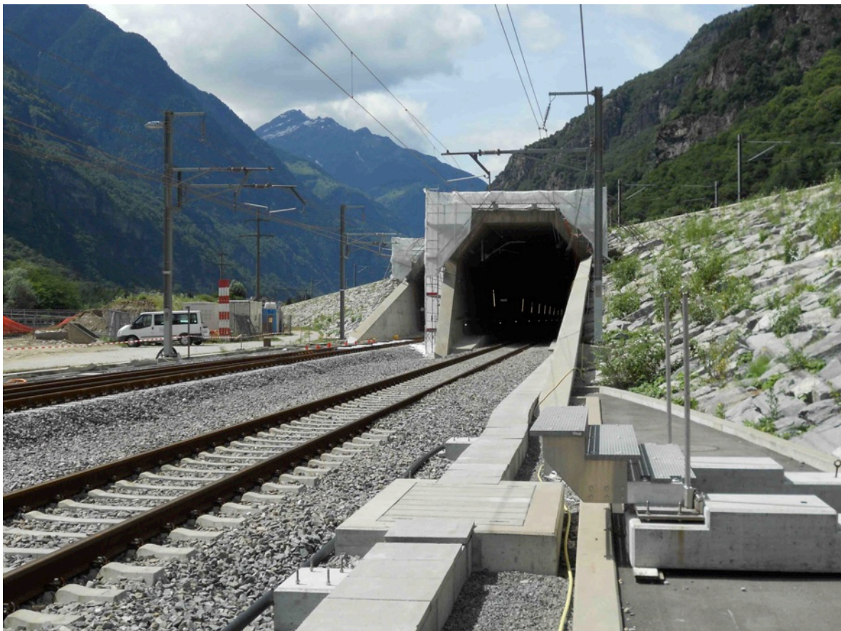
Das Südportal des Gotthard-Basistunnels in Bodio.
