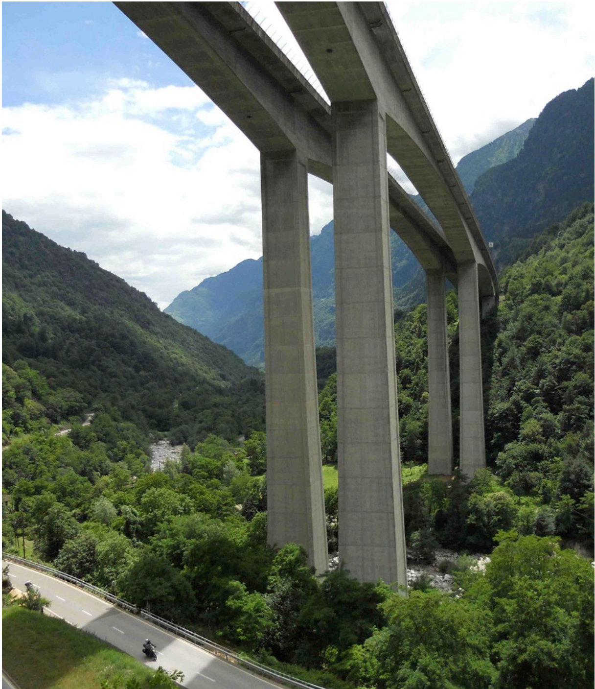
Der elegante Biaschina-Viadukt der Gotthardautobahn zwischen Lavorgo und Giornico ist mit 110 Meter über Talgrund eine der höchsten Brücken der Schweiz. Die Bauwerke auf der Tessiner Seite der A2 tragen die Handschrift des Architekten Rino Tami.
