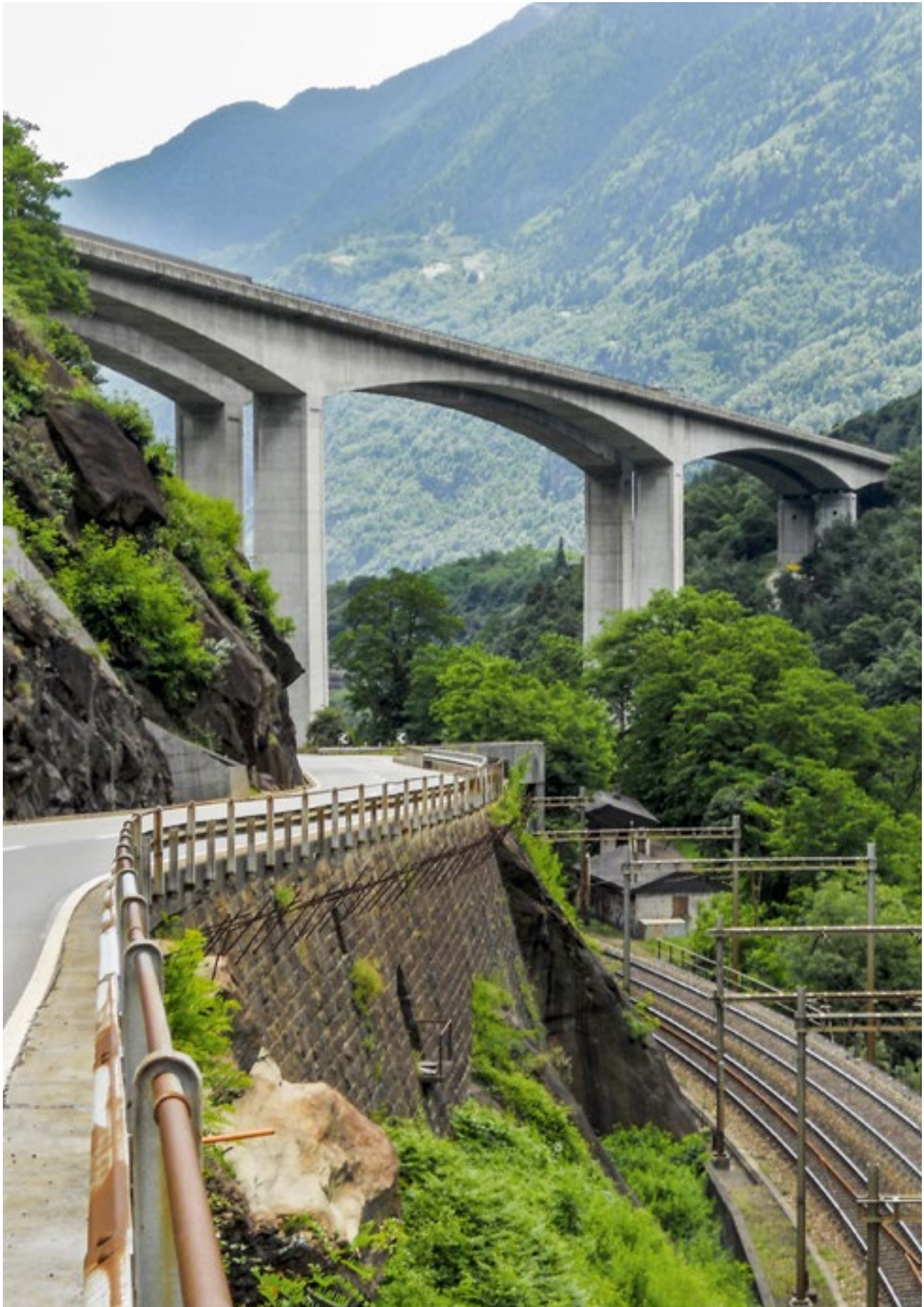
Verkehrslandschaft Leventina: Kantonsstrasse, Autobahn und Eisenbahn zwängen sich durch die Biaschina zwischen Lavorgo und Giornico. Der elegante Biaschina-Viadukt ist mit 110 m über Talgrund eines der höchsten Brückenbauwerke der Schweiz.
