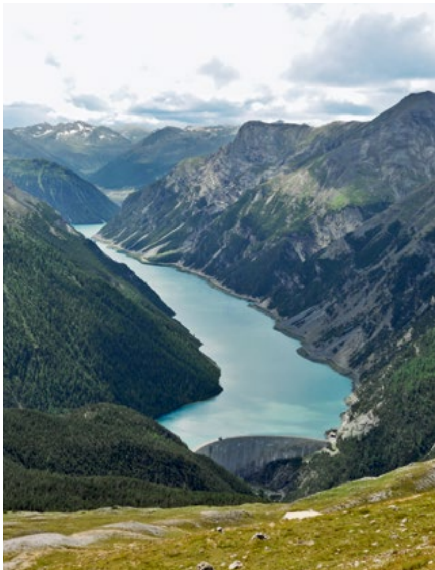
Blick vom Munt la Schera nach Livigno: Die 130 m hohe doppelt gekrümmte Bogenstaumauer (Kronenlänge: 540 m) liegt genau auf der schweizerisch-italienischen Grenze. Unterhalb der Staumauer beginnt das Gebiet des Schweizerischen Nationalparks, durch den der Spöl fließt.
