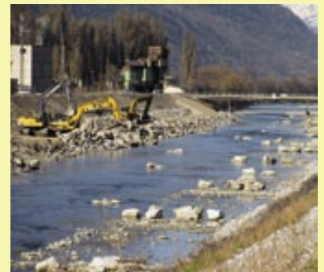
05 Stand der Arbeiten in Visp im April 2011 (Foto: Staat Wallis – Rhoneprojekt)
